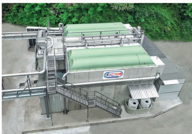
Impianto biologico per il trattamento e riciclo acque reflue industriali prodotte in seguito alle attività di finissaggio e tintura della lana, funzionante con tecnologia MBR. Installazione presso LORO PIANA - QUARONA (VC) Biological waste water purification plant, equipped with MBR technology, for the treatment and recycling of industrial waste water resulted from wool finishing and dyeing activities. Installation at LORO PIANA - QUARONA (VC)
